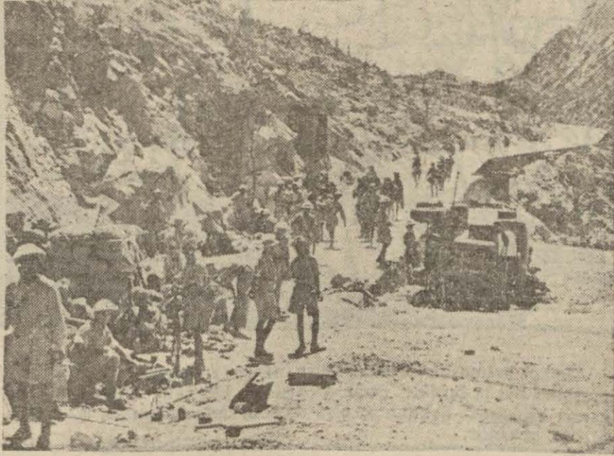
İmparatorluk kuvvetleri Afrıkada İtalyanlar tarafından tahrib edilen yolları temizleyip, açıyorlar
